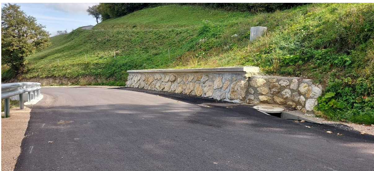
Sanacija plazov na cesti Žegar – Hrastje
