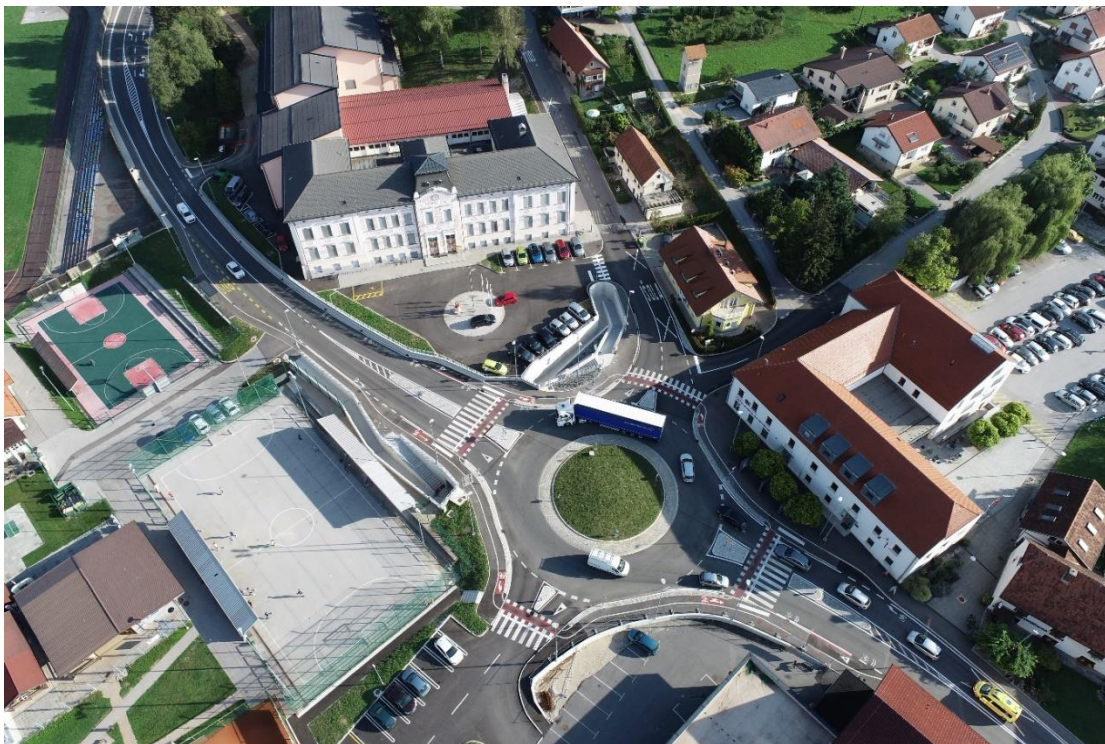
Rekonstrukcija regionalne ceste v centru Šentjurju s krožiščem in podhodom
