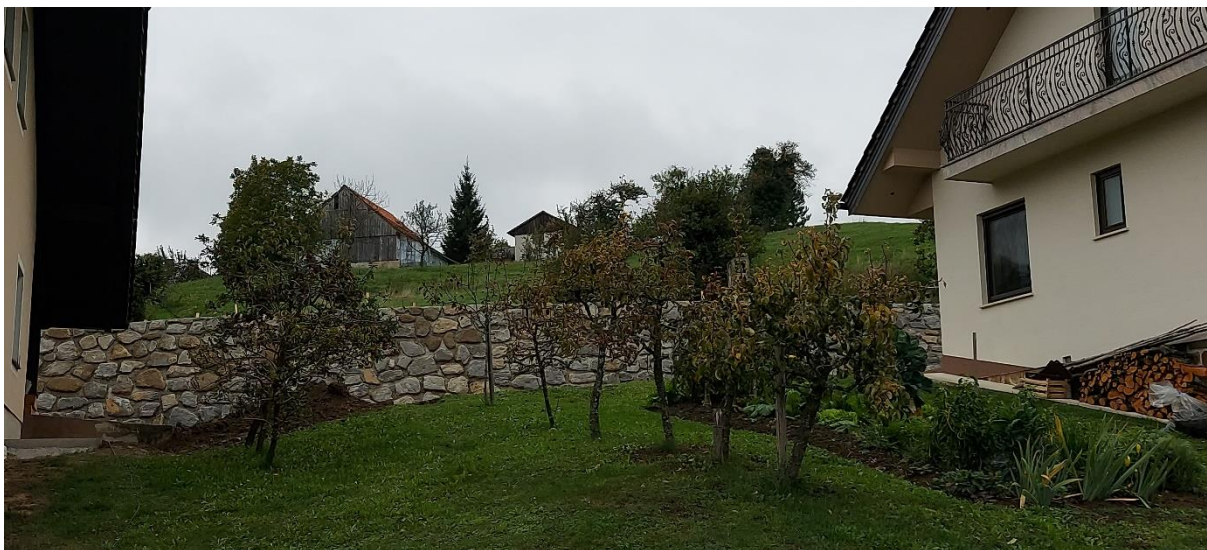
Sanacija plazu na Planini za objektom Planina 85
