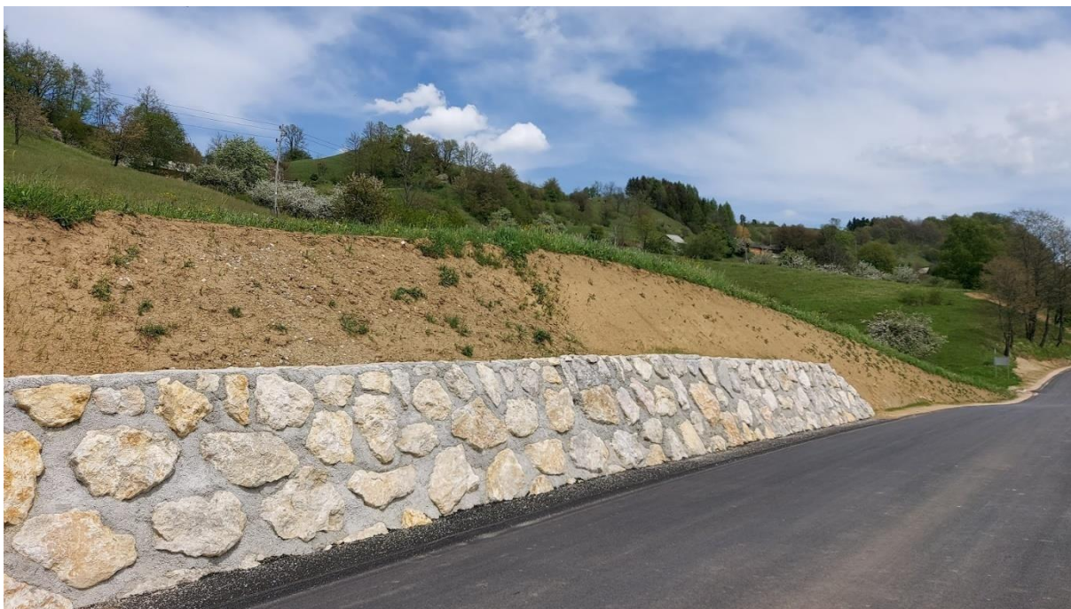
Sanacija plazov na lokalni cesti Planina – Šentvid
