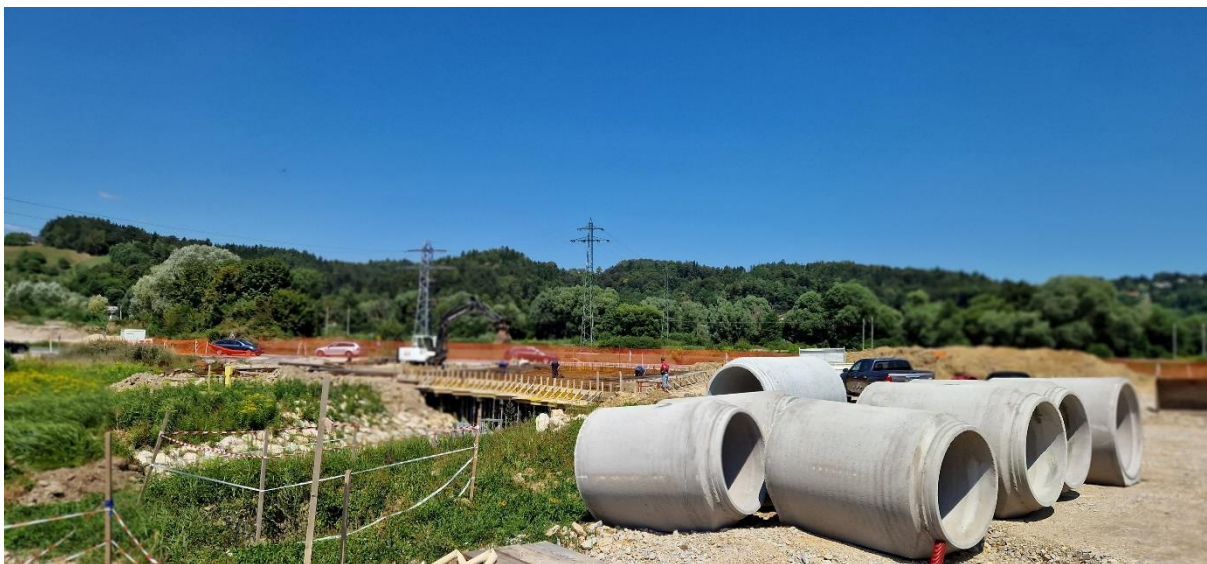
Gradnja krožišča v okviru urejanja industrijske cone Šentjur-jug 3
