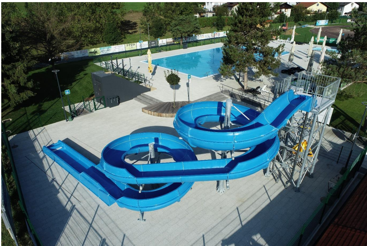
Sanacija bazena in postavitve tobogana v Športnem parku Šentjur
