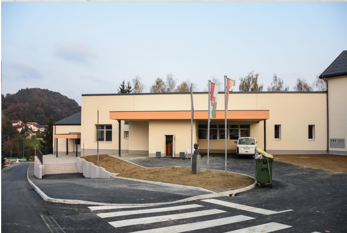
Energetska sanacija OŠ Slivnica pri Celju
