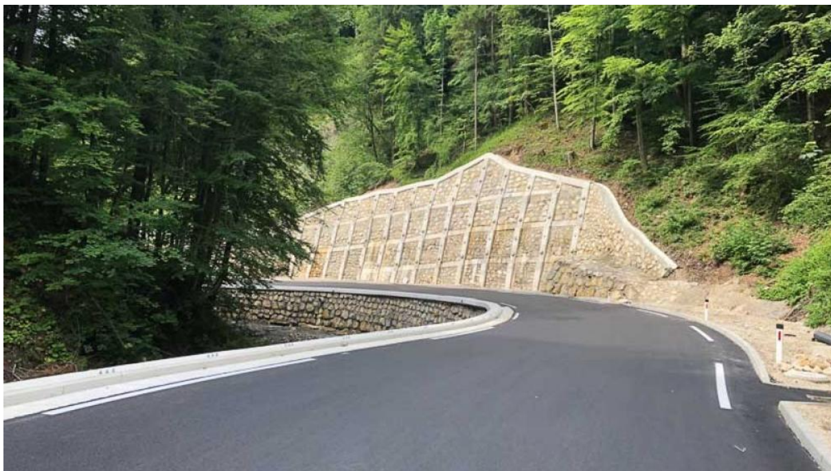
Asfaltirana cesta Planina – Sevnica
